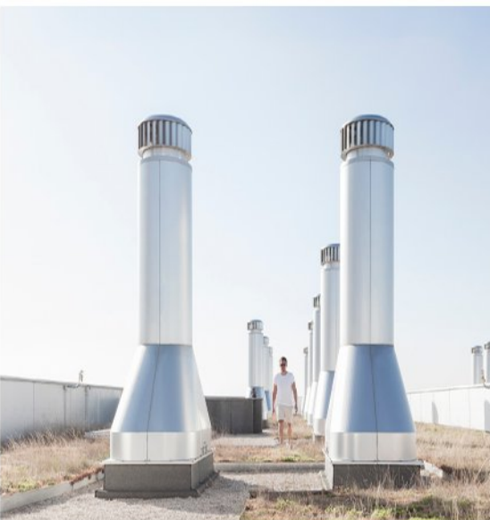
Toiture bâtiment Max Weber - Université de Nanterre
